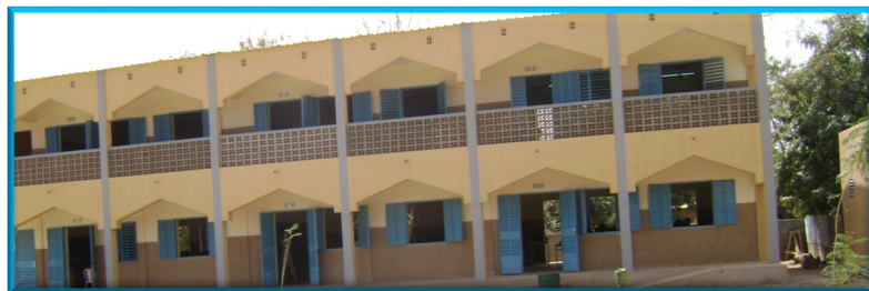
Construção de 6 salas de aula. Escola de San Jose Sâaba. (Burkina).
